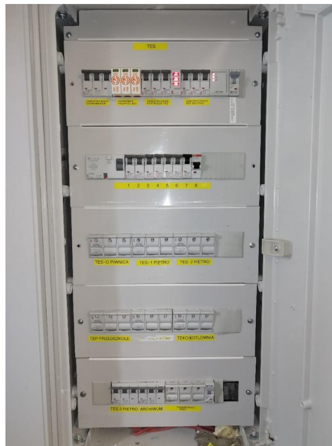
Figura 4 Podrozdzielnia – alternatywne miejsce wpięcia instalacji
