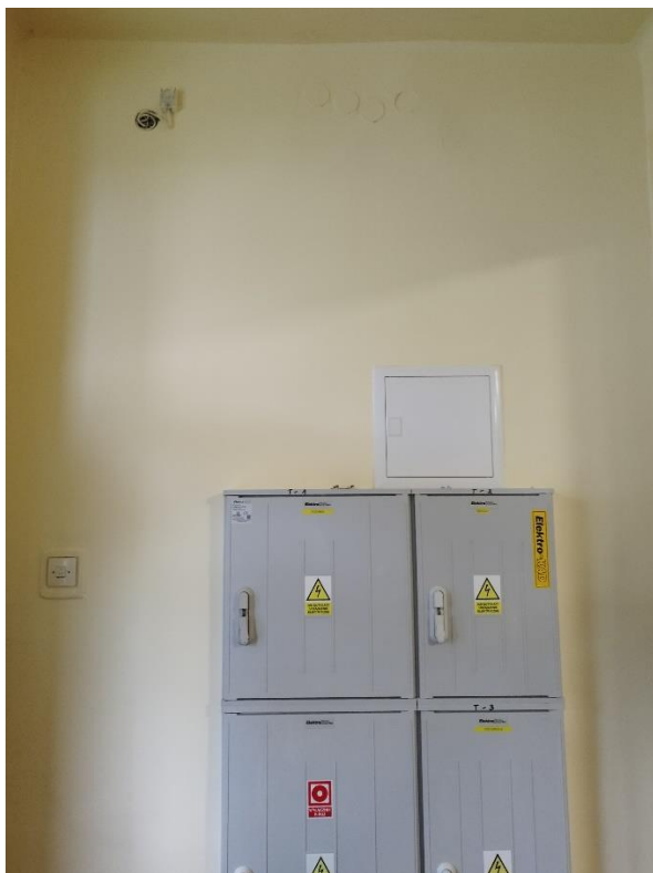
Figura 6 Główna rozdzielnia elektryczna
