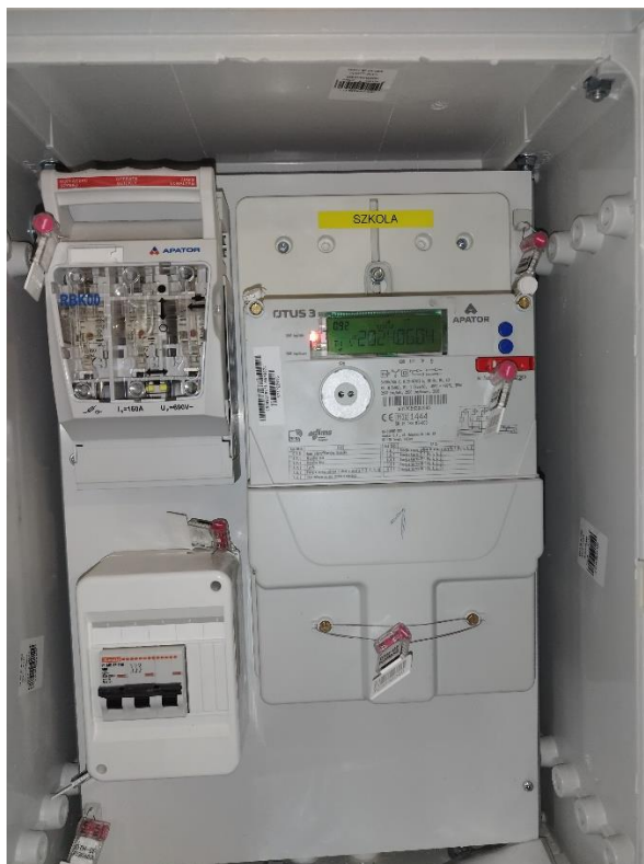
Figura 7 Widok licznika wraz z zabezpieczeniami
