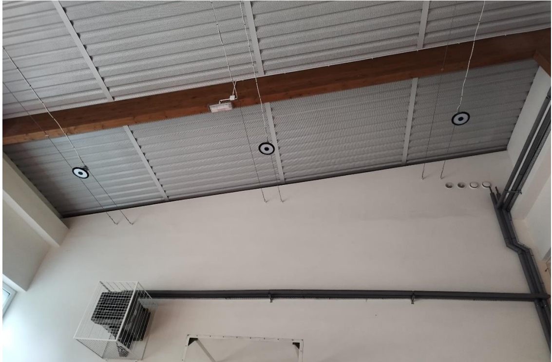
Figura 3 Zejście okablowaniem wzdłuż dachu
